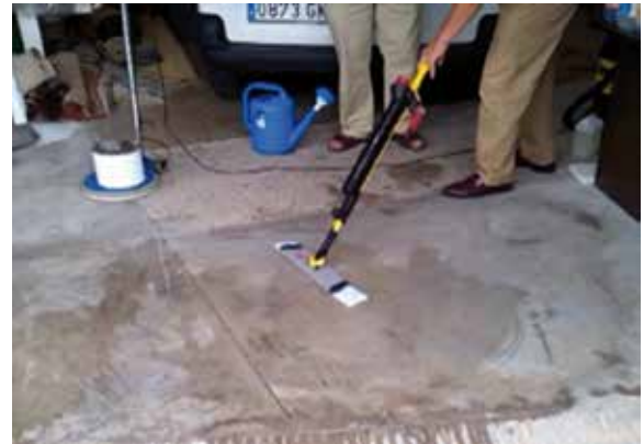
Reparto con mopa de Rplate por la zona a tratar
