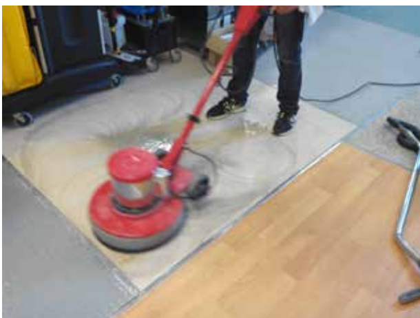
Decapado de linoleum con rotativa y Eco Clean Floor
